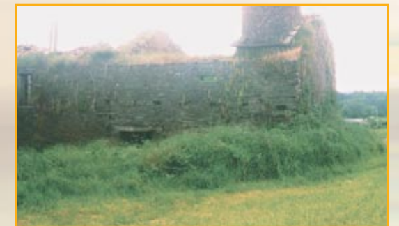
Casa dos Capeláns (actual estado ruinoso)
